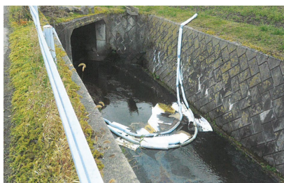
(河川流出した危険物を吸着材で回収する様子)
